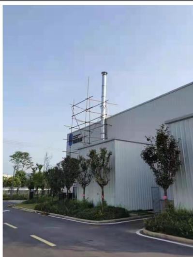
水性胶挥发的有机废气处理装置和排气筒
